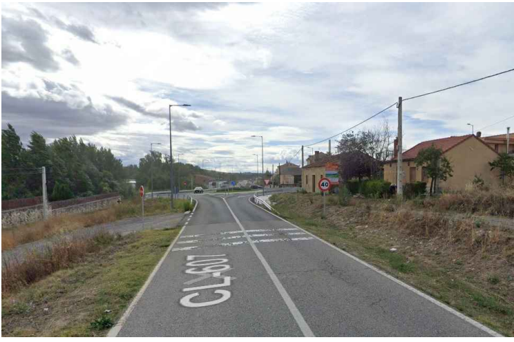
PK 3+342. FINAL OBRA. GLORIETA CL-607
