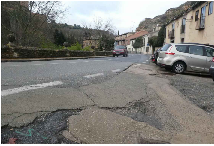
PK 1+720. SALIDA PASARELA SAN MARCOS
