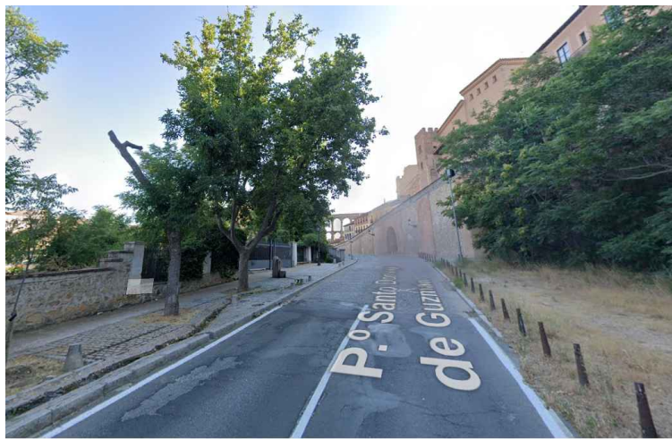
INICIO ACUEDUCTO. ZONA ADOQUIN
