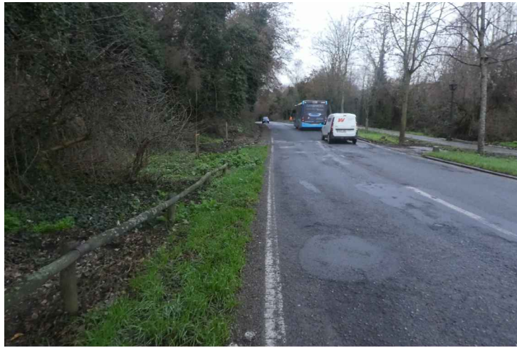
PK 1+250. ESTADO FIRME, ESTADO CUNETAS
