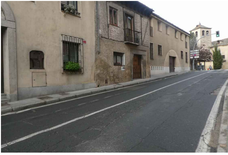
PK 1+900. ZONA ESTRECHA SAN MARCOS
