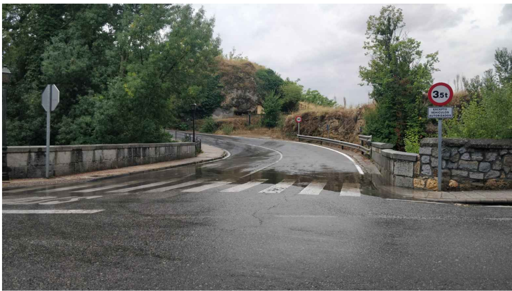
FINAL DE ACTUACIÓN. ENTROQUE CON PASEO STO. DOMINGO
