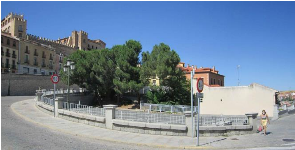
Estado actual de la Plaza Oriental
