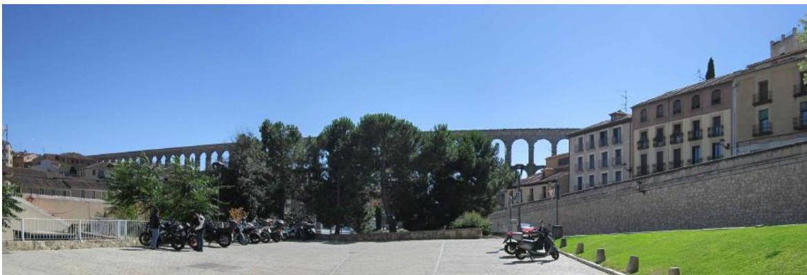
Estado actual de la plataforma superior de la Plaza Oriental
